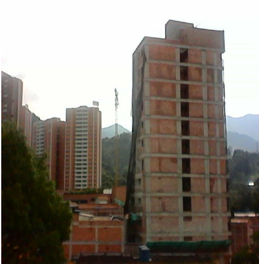
Construcciones a gran altura al lado del colegio
